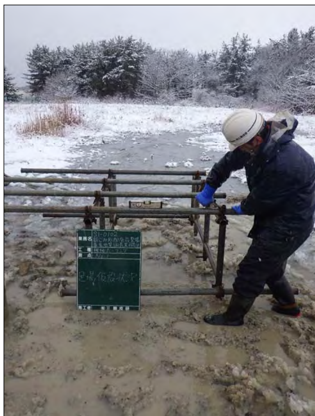
足 場 仮 設 状 況
