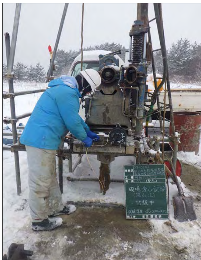
現場透水試験(揚水法)試験中 (試験深度 GL-3.00m~3.50m)
