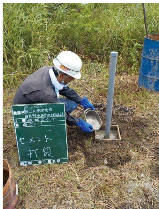
セメント打設
