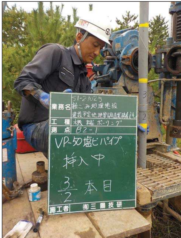
塩ビパイプ挿入中3/2本目
