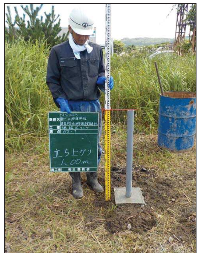
塩ビパイプ立ち上がり
