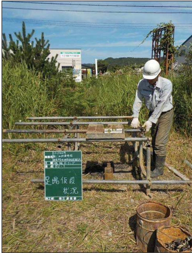
足場仮設状況
