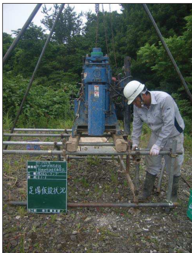
足 場 仮 設 状 況
