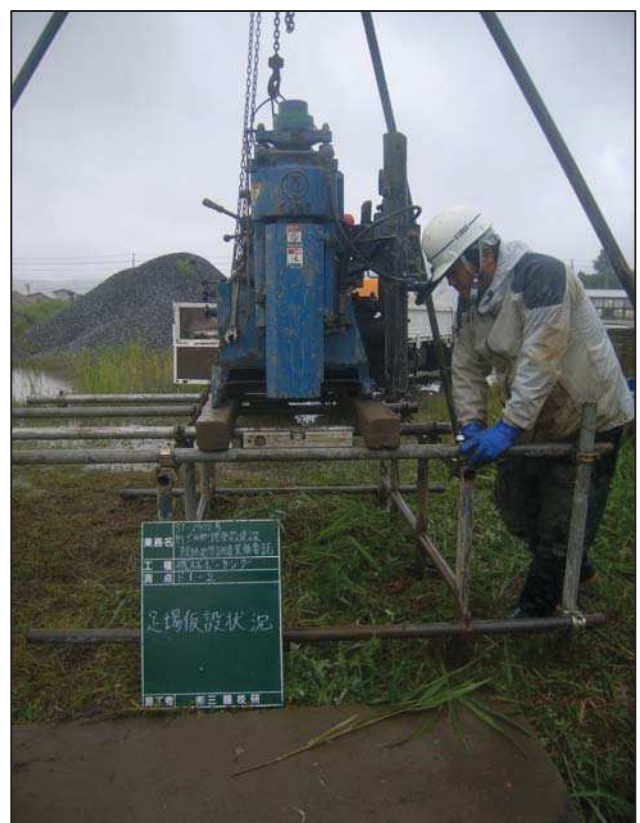
足 場 仮 設 状 況
